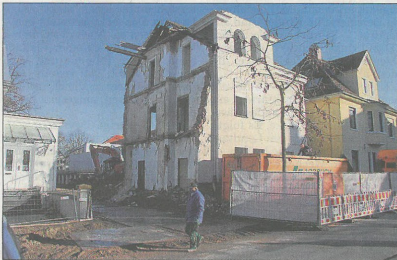
An der Hohenzollernstraße wird der Altbau mit der Hausnummer 32 neben dem Stadtarchiv (rechts) abgerissen. Bild: Dinkel
